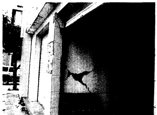
图 5 姚渡镇砖混民居破坏 (IX 度区)
