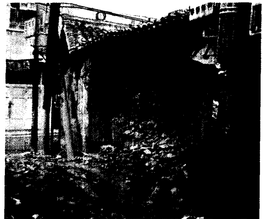
图2 文县的砾石堆砌墙体塌落(VIII度区)
