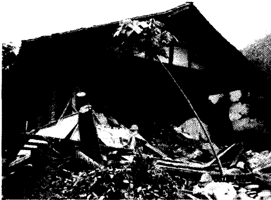
图 3 文县碧口镇木构架承重房屋局部倒塌 (IX 度区)
